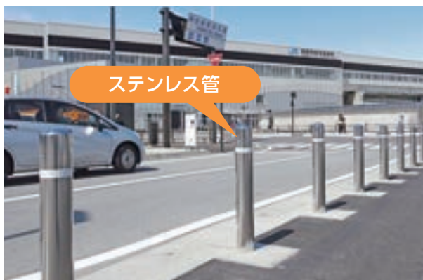
車止めパイプ
